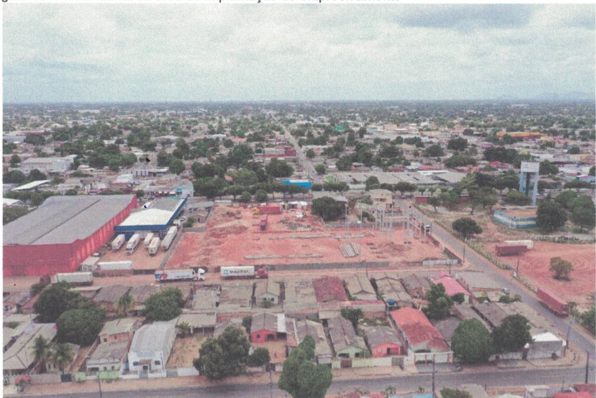
Figura 08 – Vista da área de fundos do empreendimento
