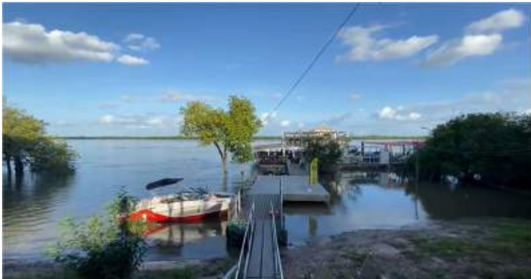
Figura 5-12. Pier de atracação dos barcos em Boa Vista. Fonte: https://www.youtube.com/watch?v=hikBbDAfYOY
