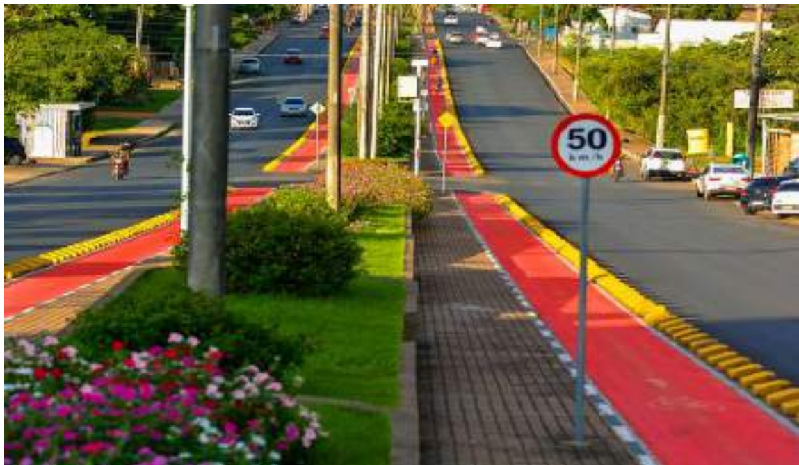
Figura 2-12 - Implementação de ciclovias na capital roraimense. Fonte: Prefeitura de Boa Vista
