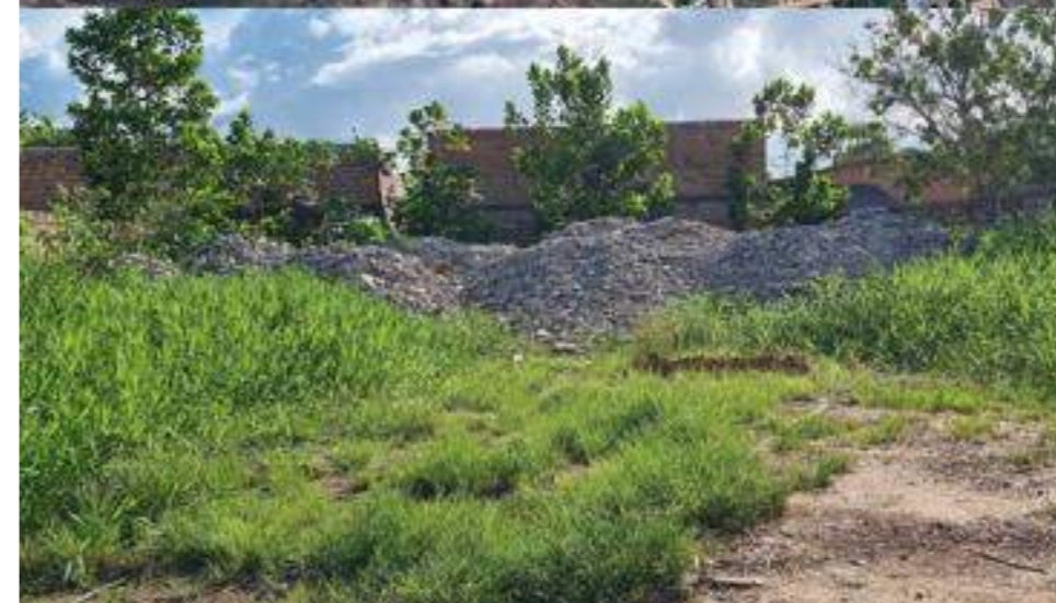
Aterramento de terreno em área de alagamento no Bairro Senador Hélio Campos (Rua HC-13).
