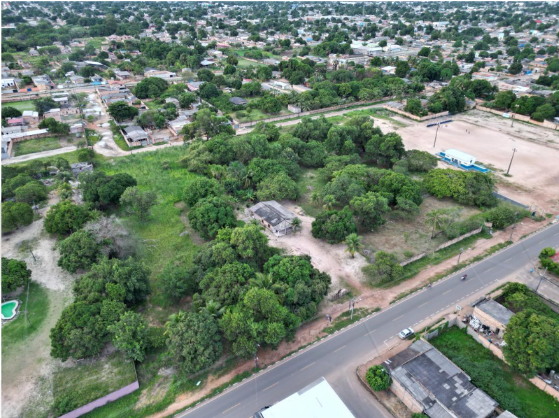
Foto 03 – Vista Frontal - Rua Izidio Galdino da Silva
