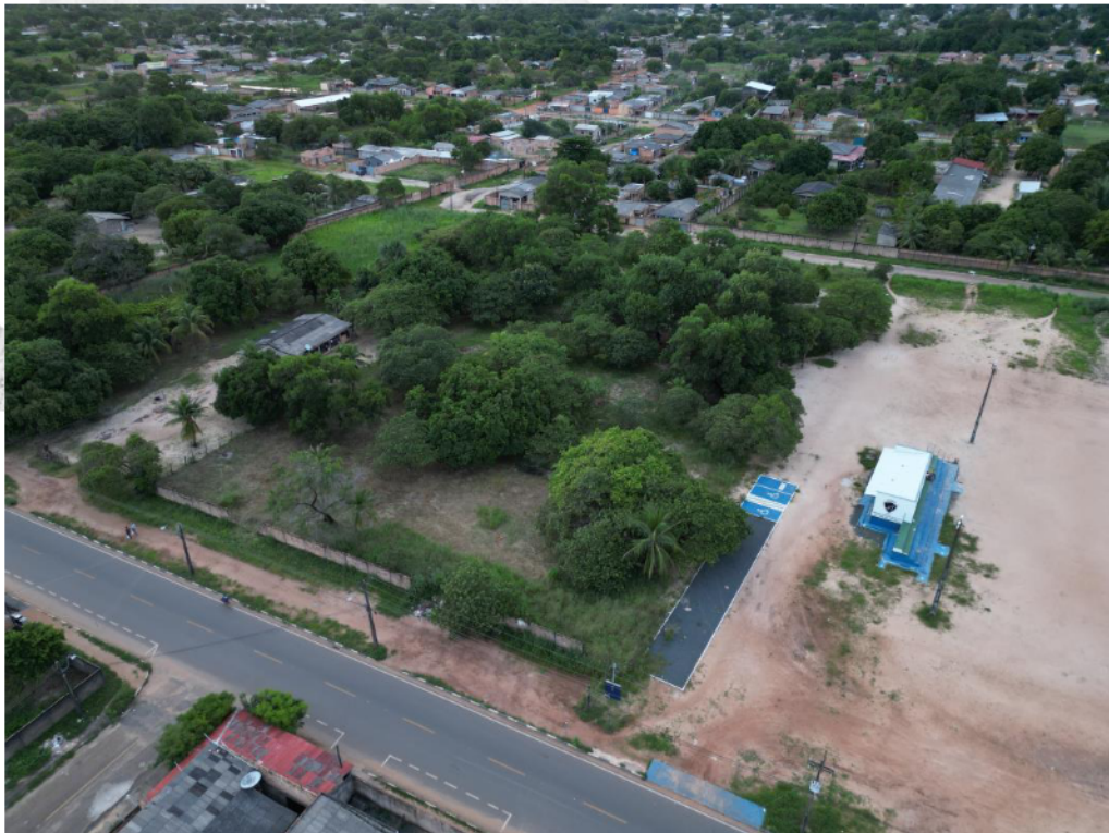
Foto 02 – Vista Frontal - Rua Izidio Galdino da Silva
