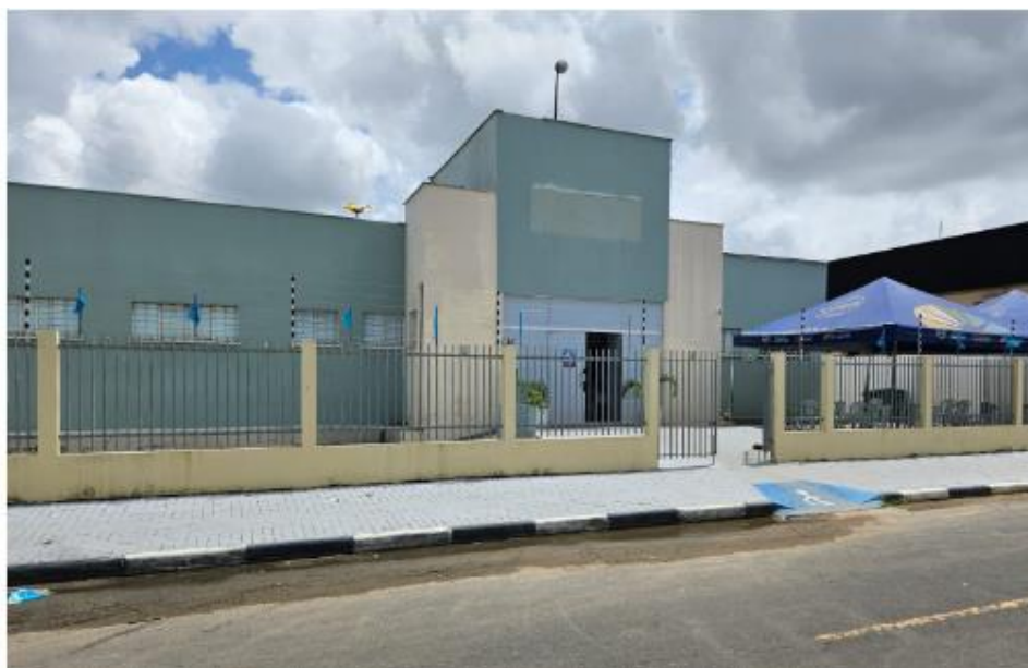
Foto 6: Unidade Básica de Saúde – UBS Arminda Gomes, localizada na Rua José Airton de Almeida, 422 - Joquei Clube.
